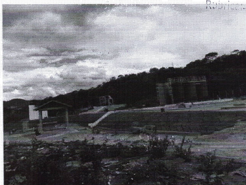
Figura 01 - Execução de plantio de grama na área da ETE - atestado Copanor
