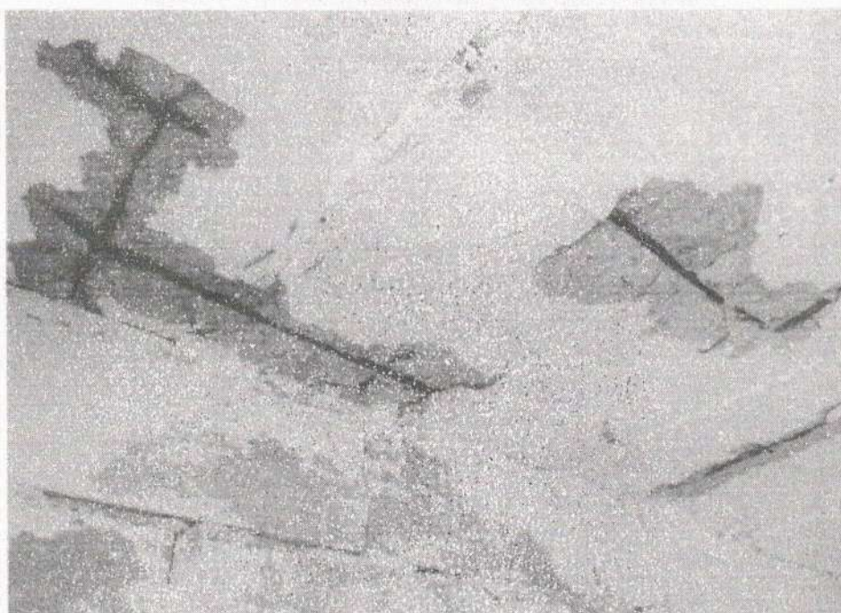
Figura 39 - Vista de ferragens na parte interna da unidade.
